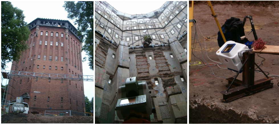
Abb. 1: Wasserturm Sternschanze Hamburg: Außenansicht (links), Innenansicht (Mitte), Scanner GS100 im Spezialstativ auf der Turmgrundebene (rechts)
