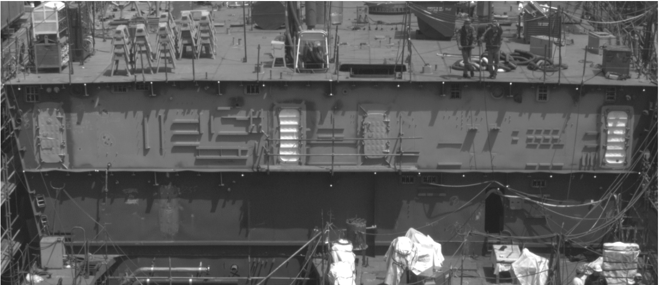
Abb. 1: Teilweise montierter Rumpf auf der Dockanlage
