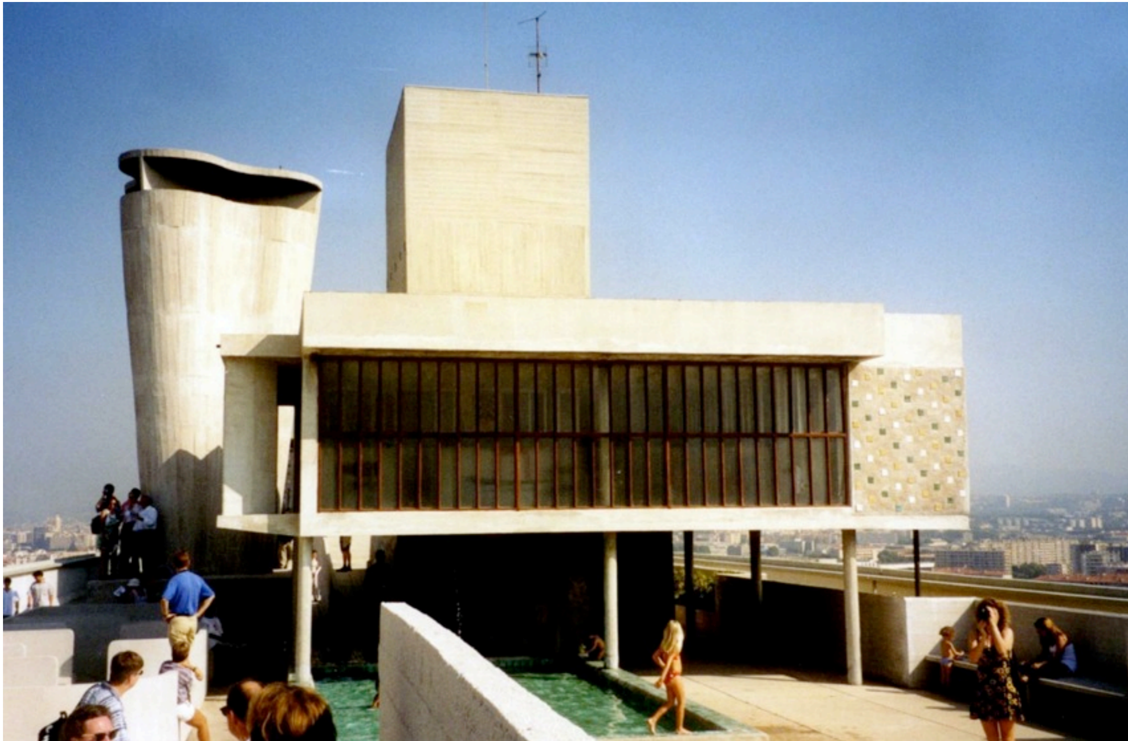
Le Corbusier Unité d' Habitation Marseille
