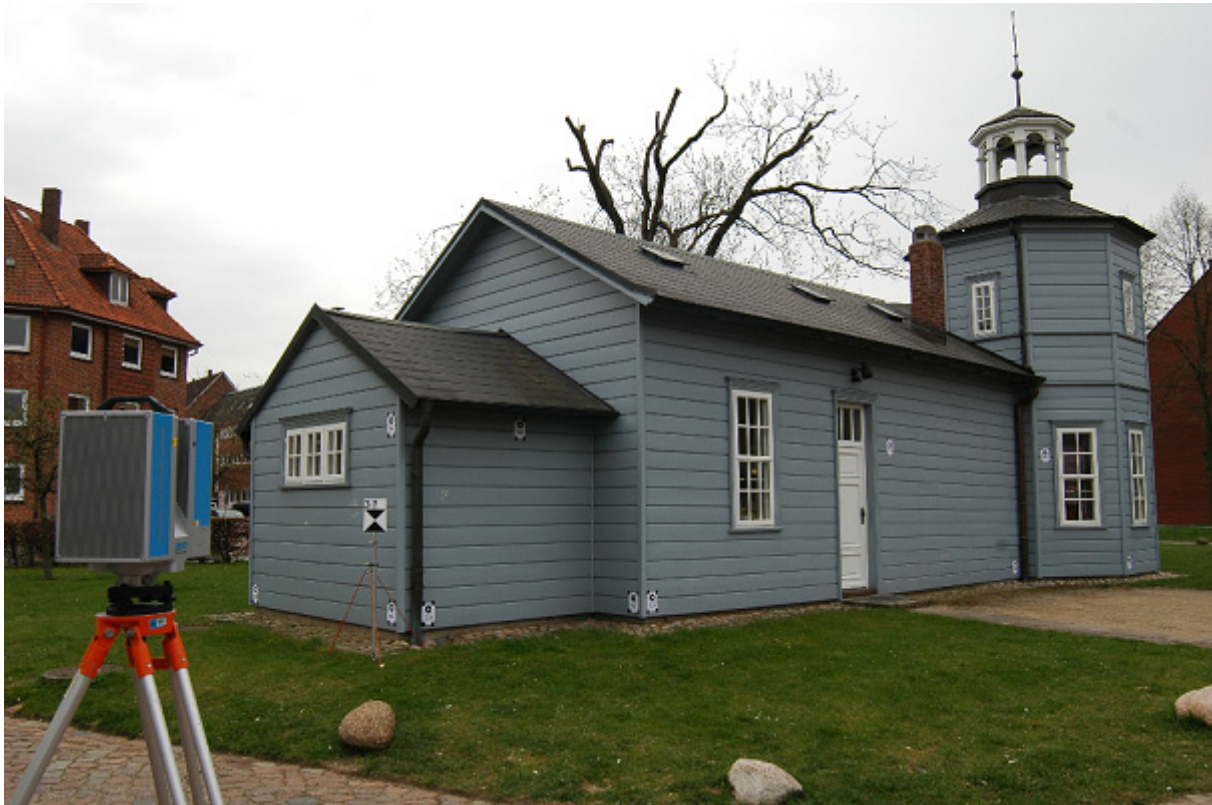
Terrestrischer Laserscanner IMAGER 5006i vor dem Alten Bahnhof in Bergedorf
