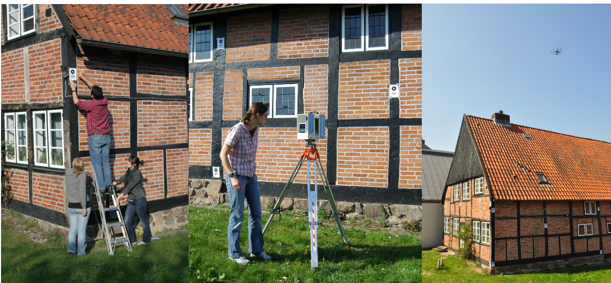
Anbringung von Vermessungspunkten (links), terrestrischer Laserscanner IMAGER 5006i vor dem Alt-Segeberger Bürgerhaus (Mitte) und Oktokopter über dem Dach des Bürgerhauses (rechts)
