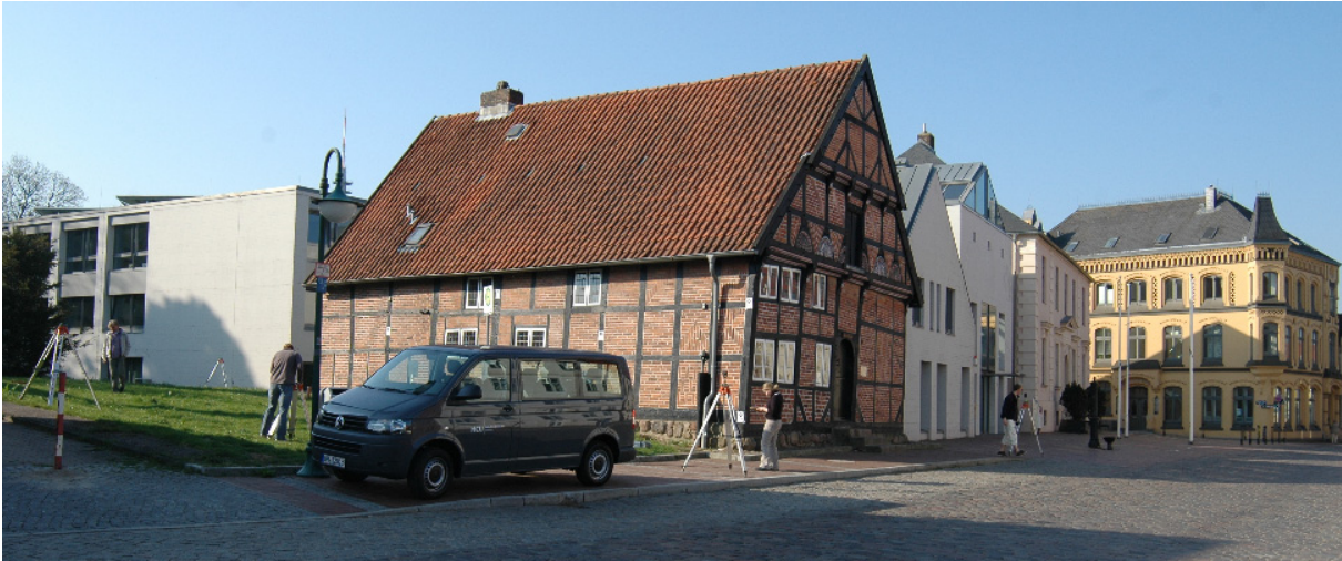
Vermessung des Alt-Segeberger Bürgerhauses mit modernen Aufnahmeverfahren (Photogrammetrie und Laserscanning)
